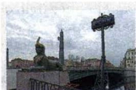
Египетский мост, построенный заново в 1954—1956 гг.
