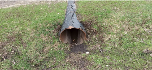
Рис.1. Входной оголовок
