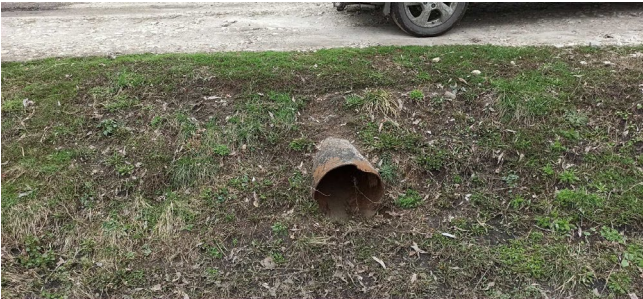
Рис.1. Входной оголовок
