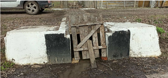
Рис.1. Входной оголовок
