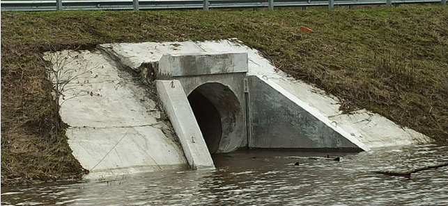
Рис.1. Входной оголовок
