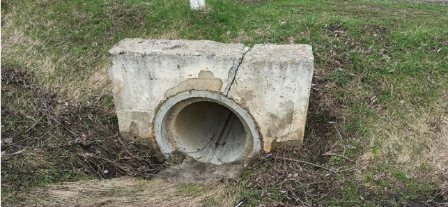
Рис.1. Входной оголовок
