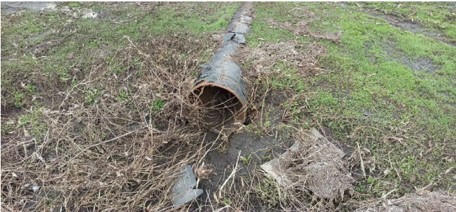
Рис.1. Входной оголовок
