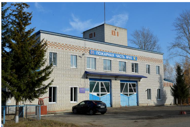
Рис. 19. Пожарная часть № 45 по охране села Янтиково (фото: АМ «Мой город». 2020 г.)
