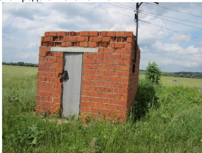
Рис. 1.16. Павильон с электрическим щитом и приборами учета электроэнергии артезианской скважины №6б с.Рындино
