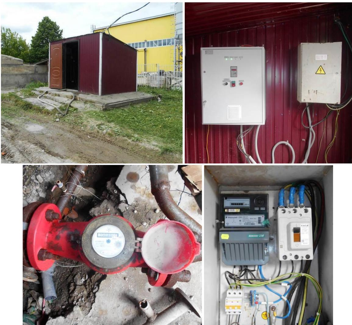
Рис. 1.26. Павильон и оборудование артезианской скважины ЦАТТ г.Цивильск
