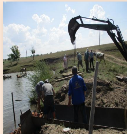
Строительство пирса в деревне Нискасы
