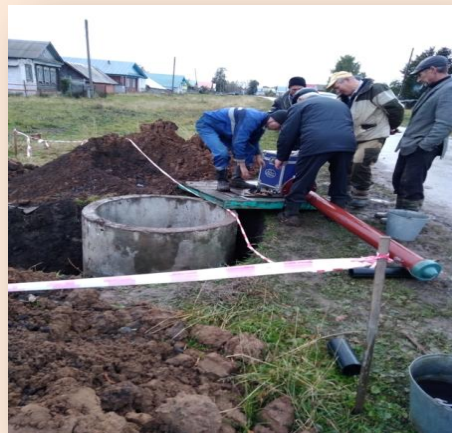
Установка гидранта в деревне Ярославка
