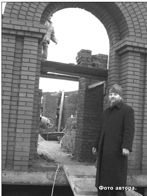
Отец Николай пристально следит за строительством Храма.
