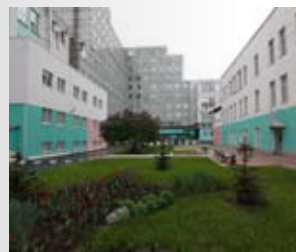
Внутренняя территория после реконструкции
