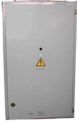
Рис. 6. Вторичный распределительный щит с автоматическими выключателями
