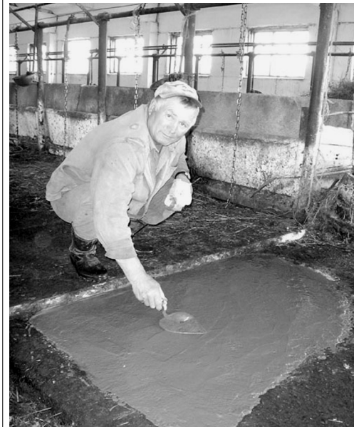
Иван Дмитриевич Поликарпов “Свобода” хуҥалáхри строительство ёсөсөнче 30 сул ытла вáй хуратъ. Паян вáл хуҥалáхри чи опылла строительсенчен пёри. Хуҥалáхра сёкленнё кашни выльáх сарайё, тырá склáчө, кёперпе пұрт-сұрт патнех ситнё унан алли. Пуян опылла строитель ял сыннисемшён те ялан кирлө сын. Пуртá е малатук, раствоор сармалли мастөкө е кёрөсө – кашниөх áста аллинче меллө ёс хатёрё.
