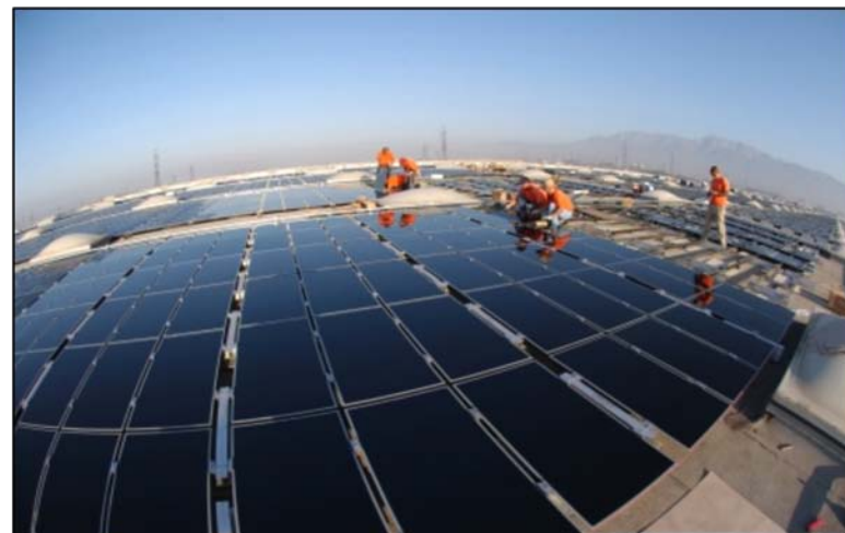
250 МВт, 600 м.кв., 33 700 тонкоплёночных модулей, Калифорния, США
