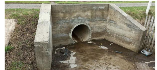
Рис.2. Выходной оголовок
