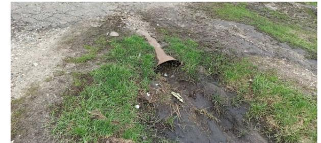
Рис.2. Выходной оголовок
