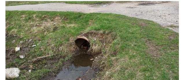
Рис.2. Выходной оголовок
