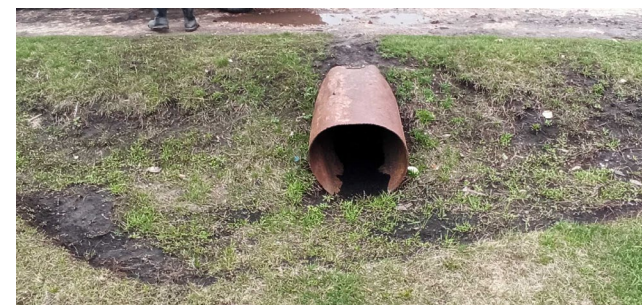
Рис.1. Входной оголовок
