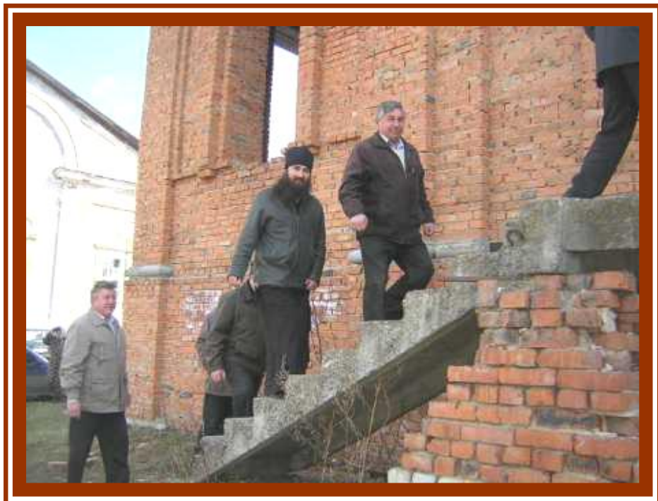
Колокольня тоже требует реставрации
