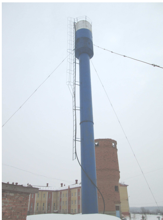
Рис. 1.8. Водонапорная башня по улице Епифанова с. Шихазаны
