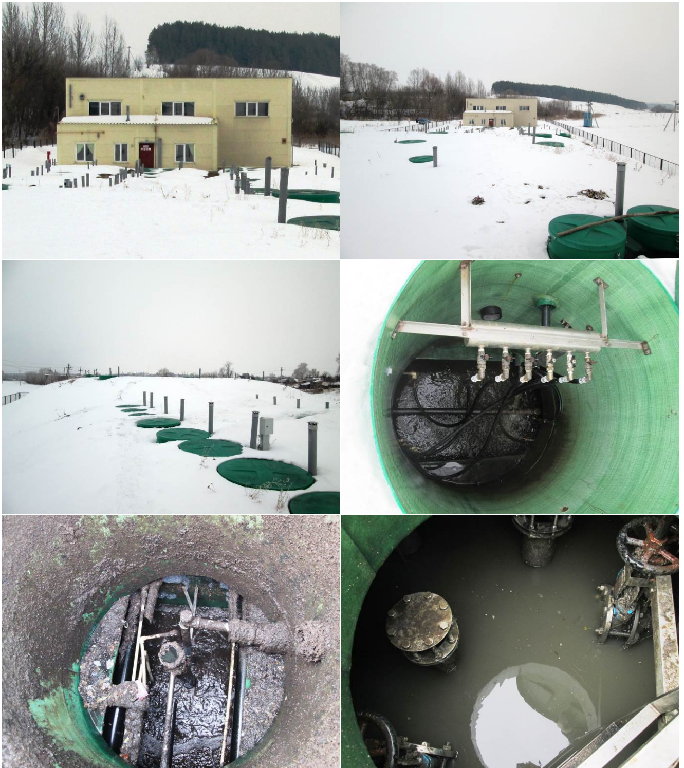
Рис. 1.1. Фотографии комплекса очистных сооружений
