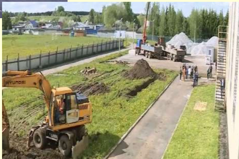
Строительство плавательного бассейна
