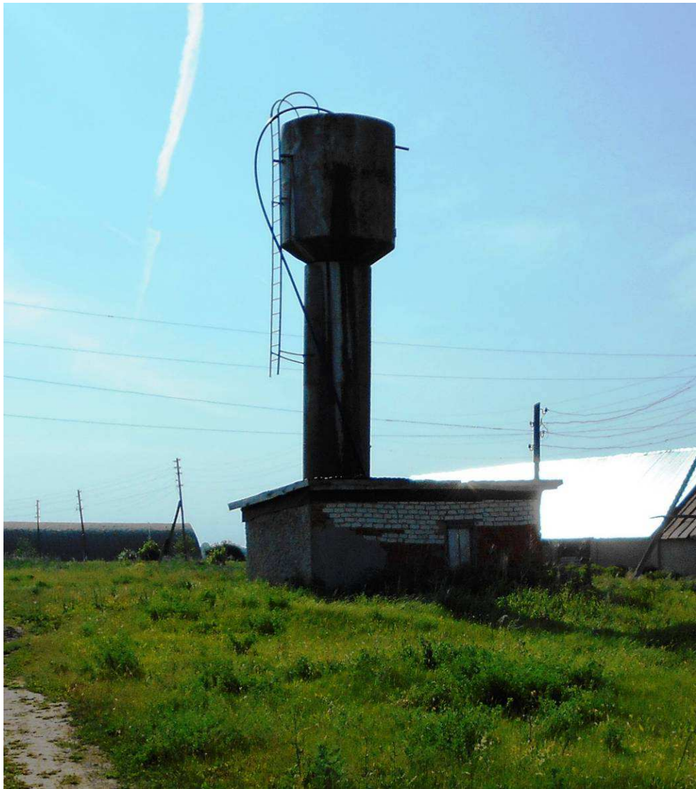
Рис. 1.10. Водонапорная башня д.Юманзары по ул.Канашская
