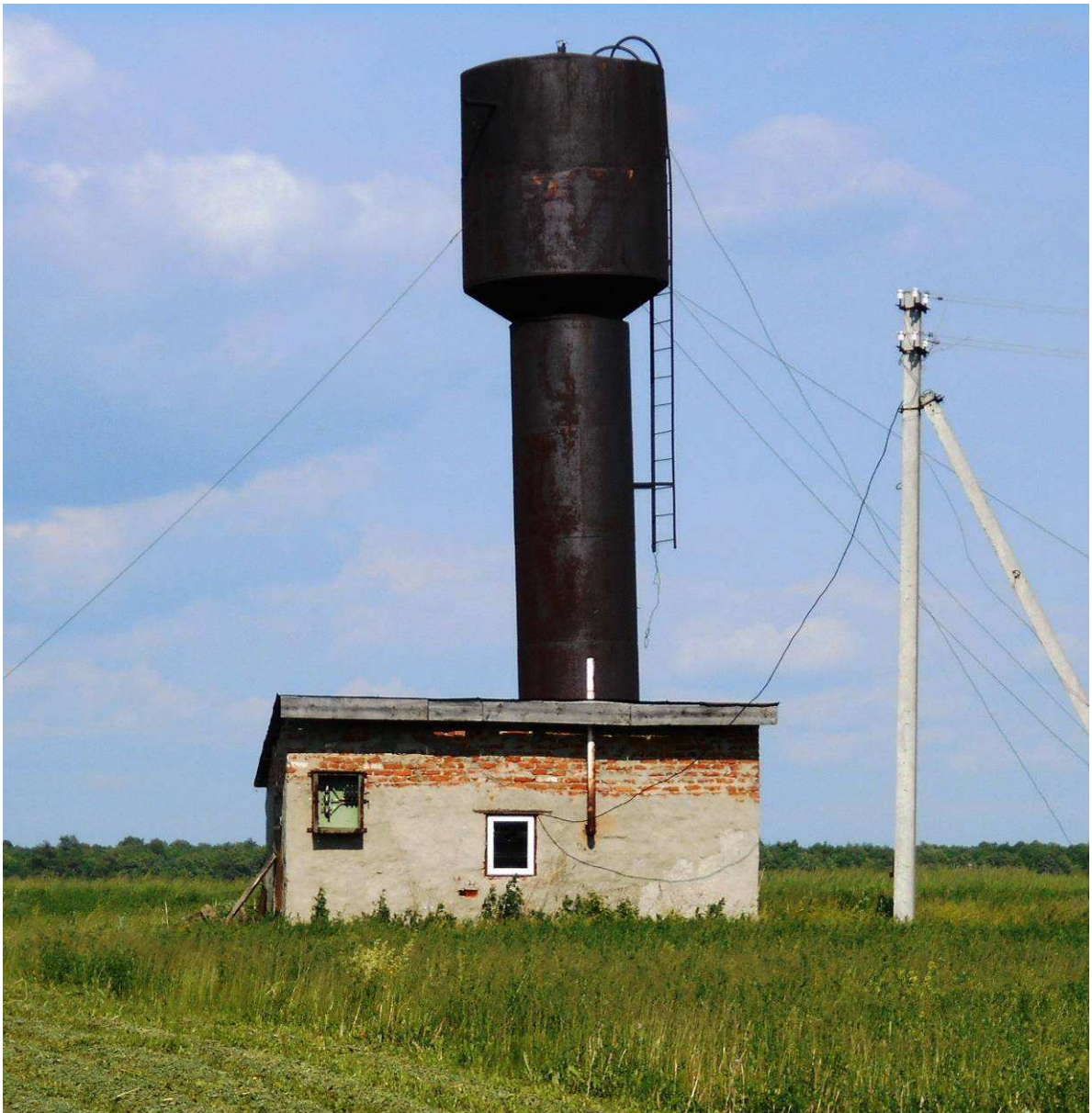
Рис. 1.12. Водонапорная башня д.Юманзары по ул.Западная
