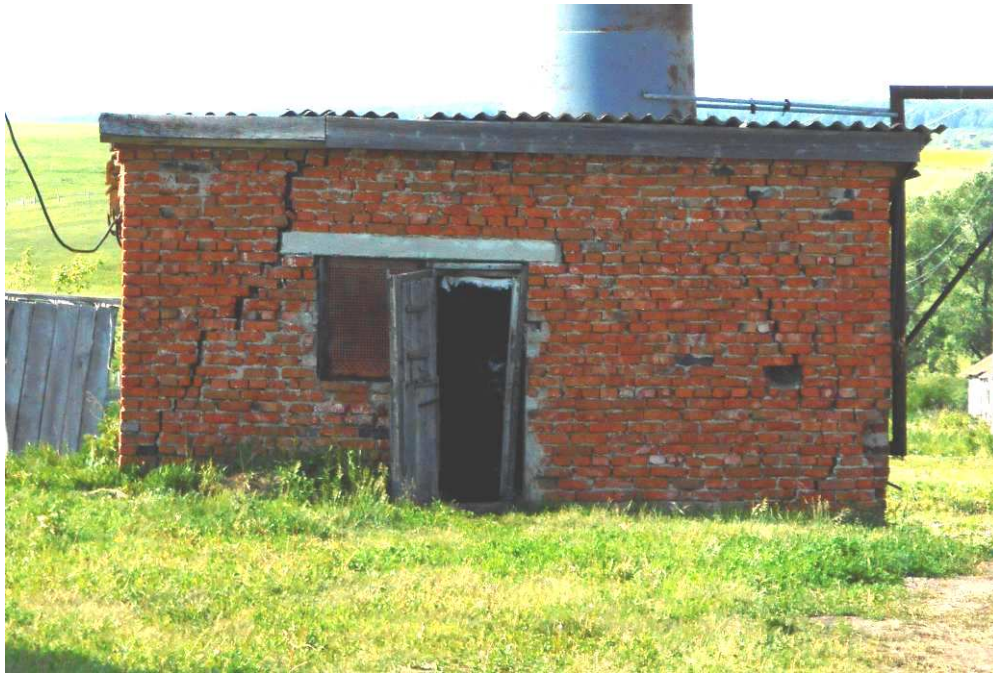
Рис. 1.5. Павильон скважины д.Караклы по ул.Шоссейная
