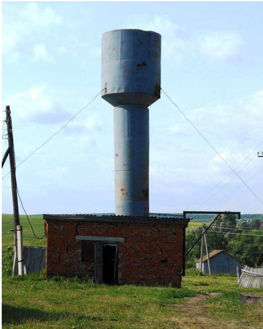
Рис. 1.6. Водонапорная башня д.Караклы по ул.Шоссейная
