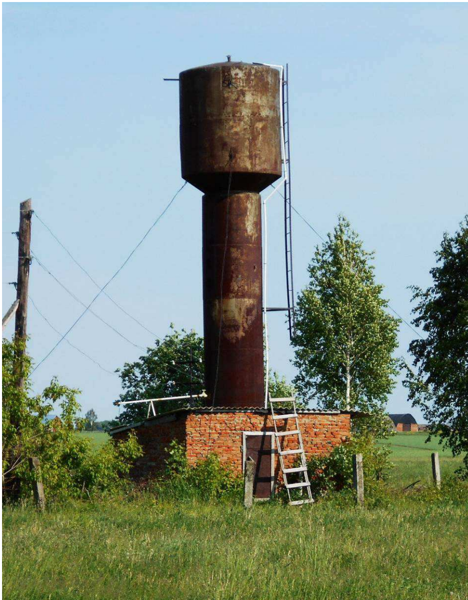
Рис. 1.8. Водонапорная башня д.Караклы по ул.Молодежная
