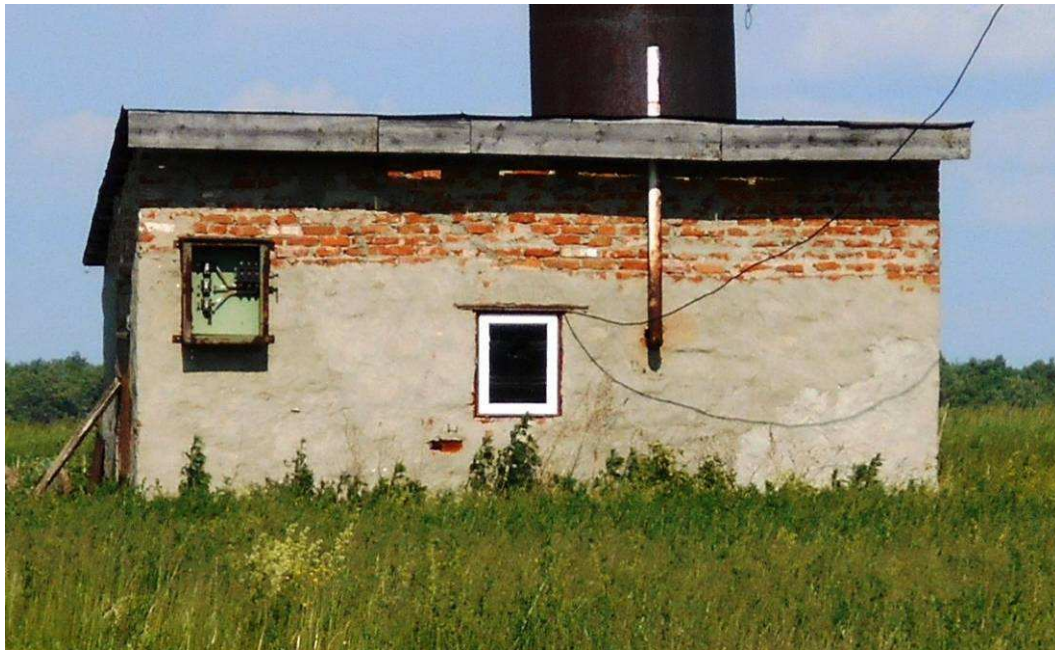
Рис. 1.11. Павильон скважины д.Юманзары по ул.Западная
