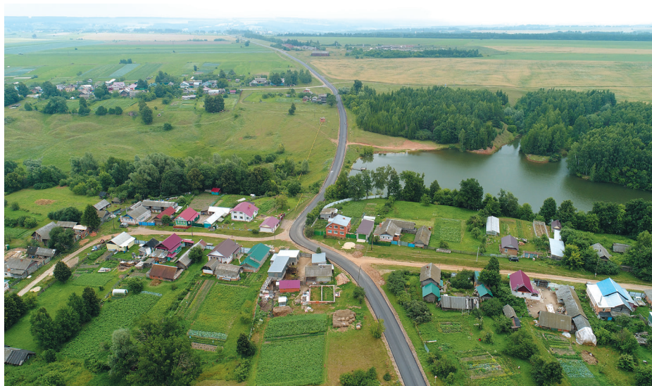
В Моргаушском районе отремонтирована автодорога «Большой Сундырь – Большое Карачкино – Ешмолай»
