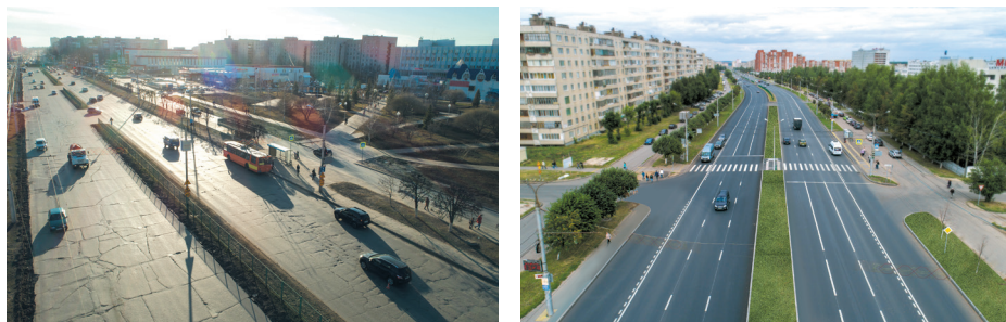
Проспект Тракторостроителей г. Чебоксары: как было и как стало
