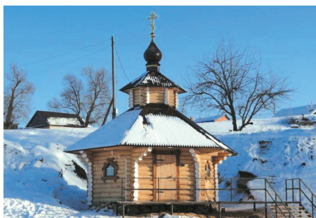
Благоустройство и ремонт «Родник Асанов» в Комсомольском районе
