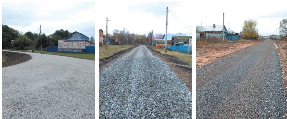
Строительство и ремонт дорог в сельских населенных пунктах
