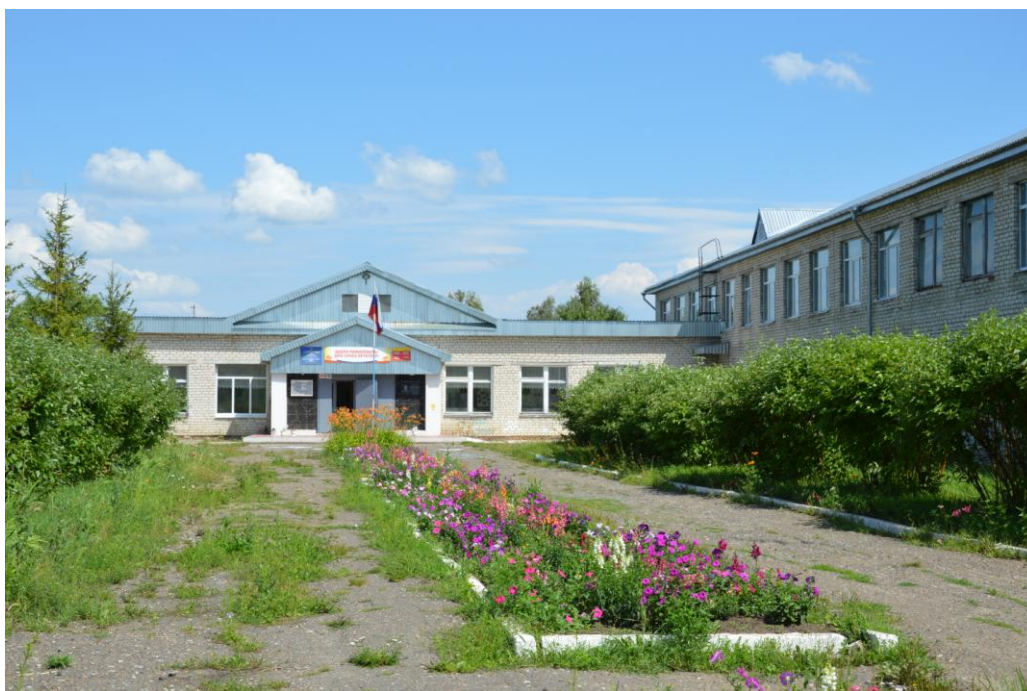
Рис. 14. Деревня Айбечи. Здание общеобразовательной школы (фото: АМ «Мой город»)
