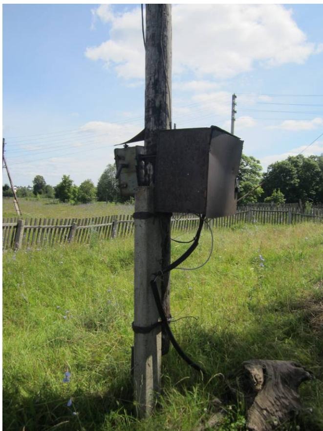
Рис. 1.21. Ящик с электрическим щитом артезианской скважины д. Ямбарусово
