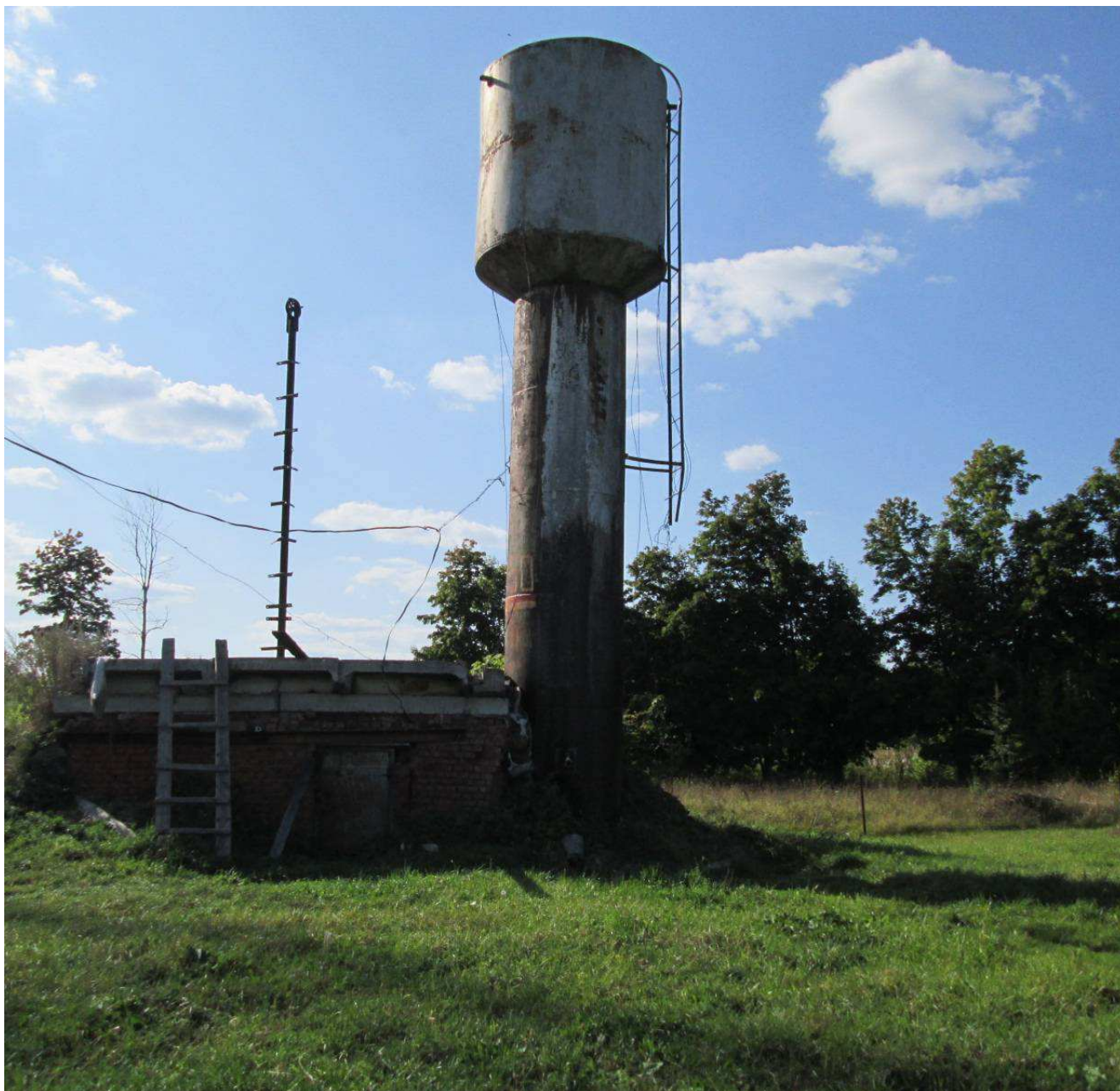
Рис. 1.14. Водонапорная башня артезианской скважины №2 д. Эльбарусово
