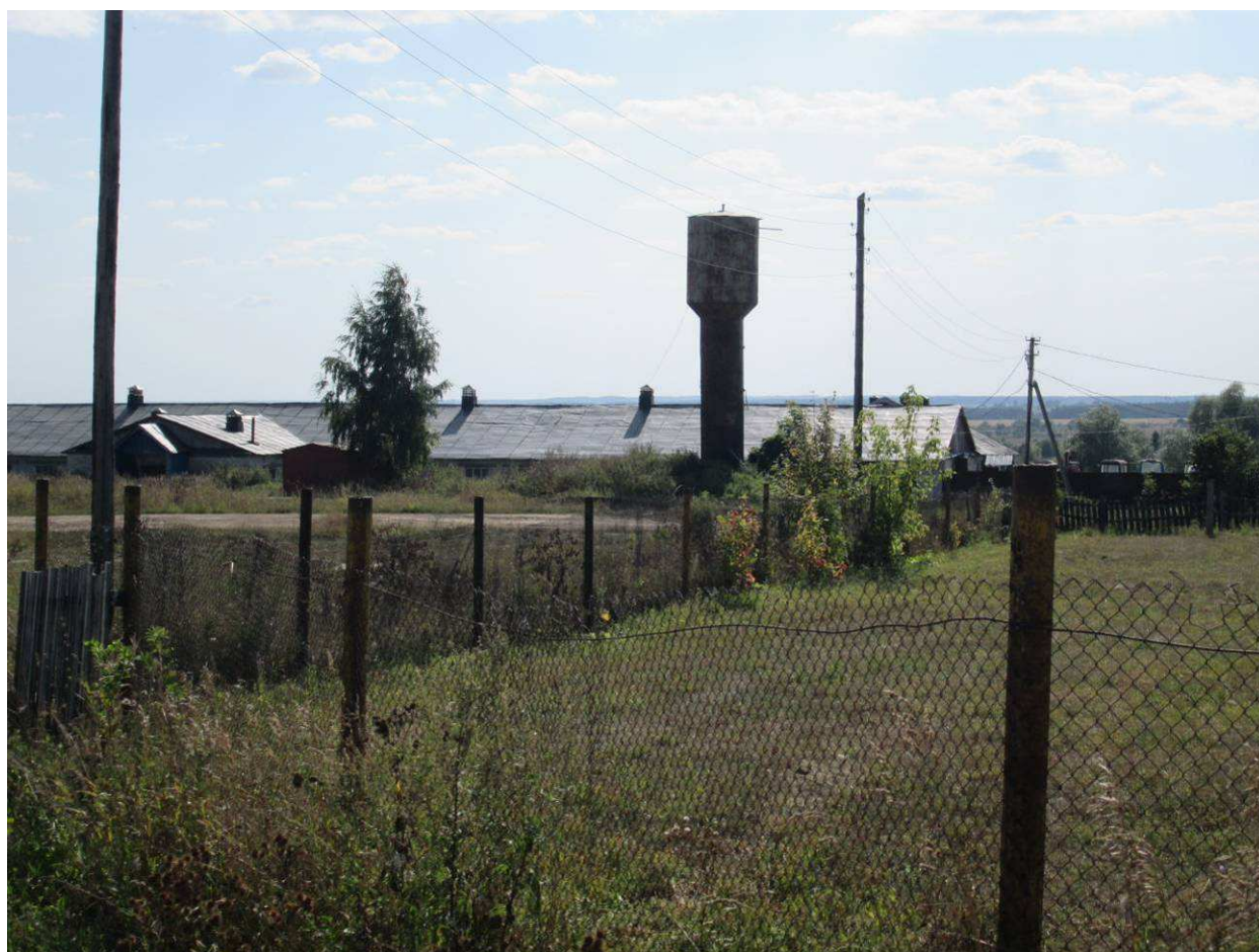
Рис. 1.20. Водонапорная башня артезианской скважины с. Тогаево
