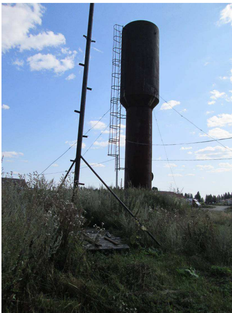
Рис. 1.12. Водонапорная башня артезианской скважины №1 д. Эльбарусово
